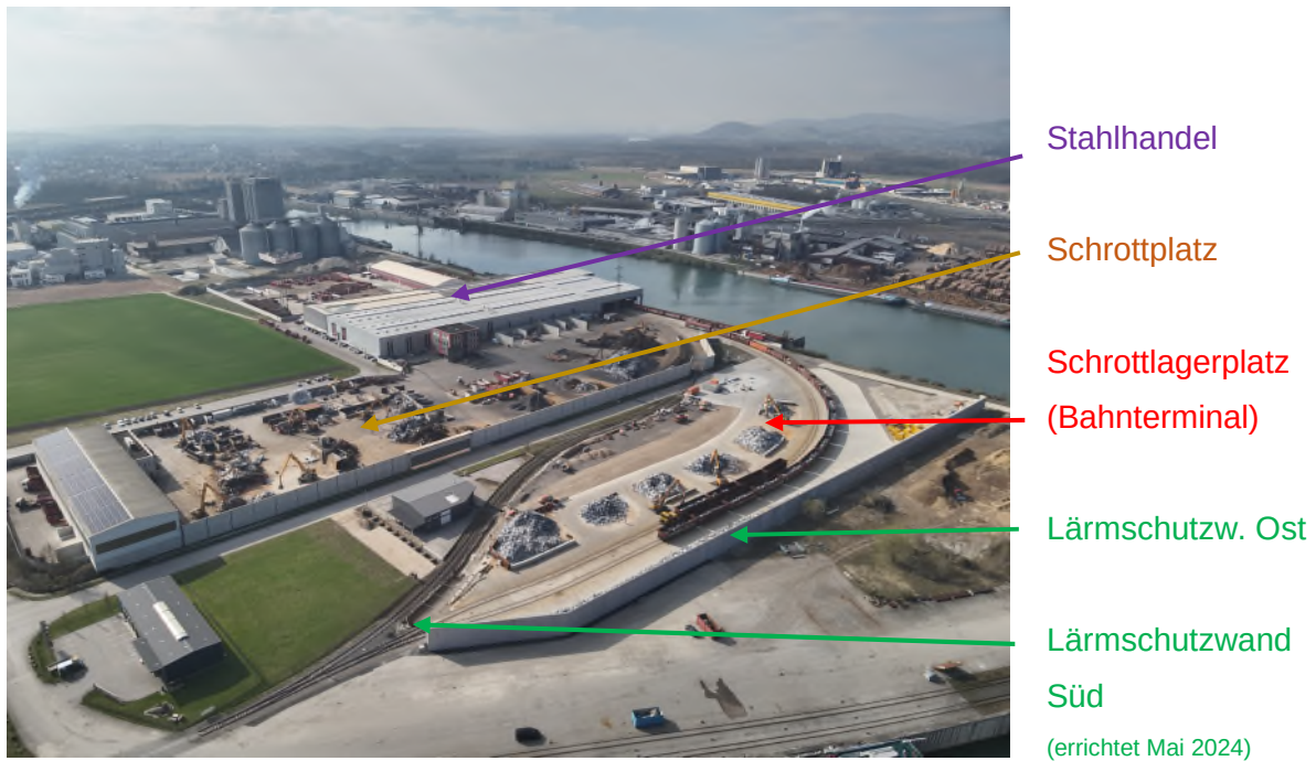
Abbildung 3: Anlagenstandort Firma Johann Neumüller GmbH; Bild aus Drohnenflug Johann Neumüller GmbH; Stand nach Ausbau Bahnterminal Gewerberechtliche Bewilligung 2023; Quelle: Johann Neumüller GmbH; vom 19. März 2024
